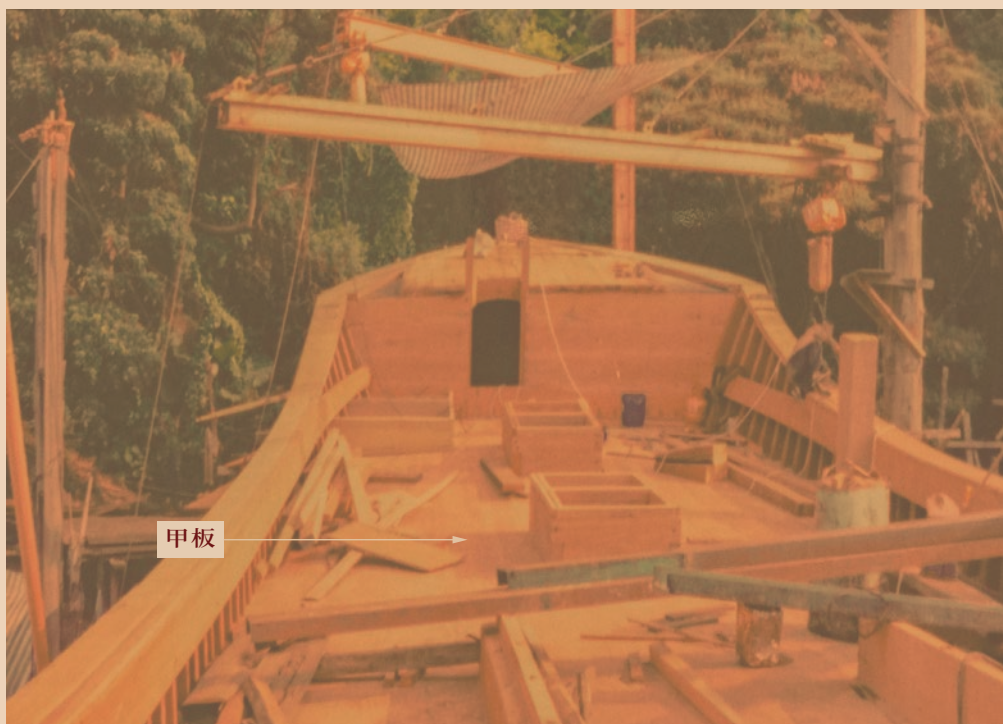
製作中的漁船甲板，長約一百尺。照片由梁偉雄師傅提供。
