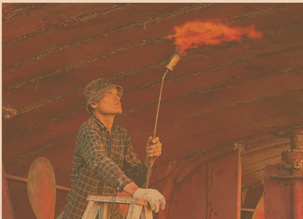
石油氣生火，烘乾船底。照片由高彤女士拍攝。
